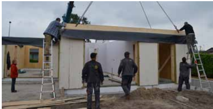
Montage houtskeltbouw 1ste verdieping
