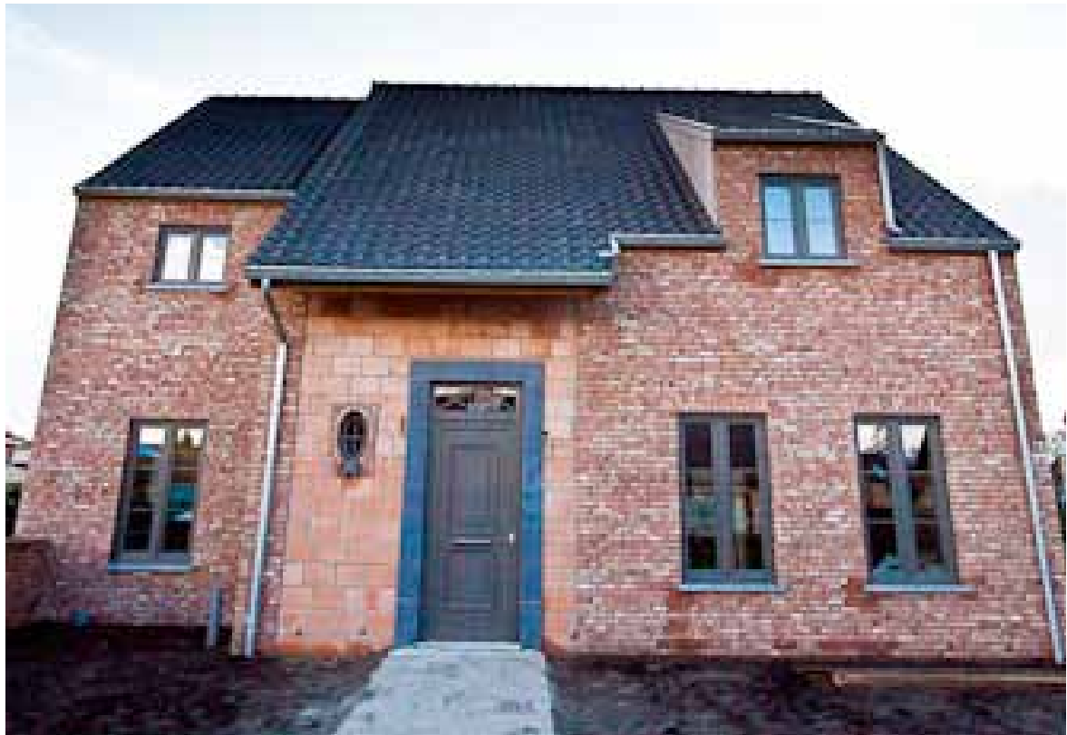
Buitenafwerking met gevelsteen, klaar om ingevoegd en bepleisterd te worden
