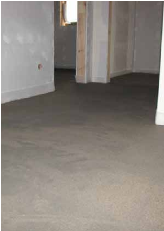
Vloer afgewerkt met chape
