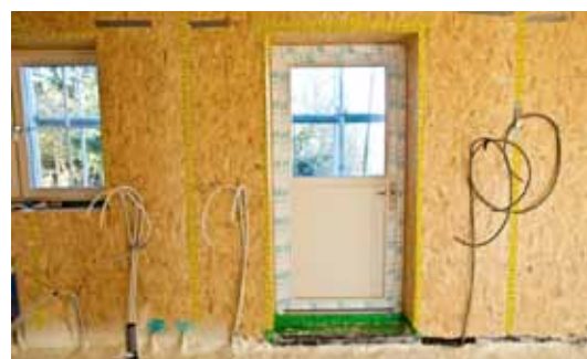
Alle naden en kieren mooi afgekleefd met luchtdichtheidsfolie
