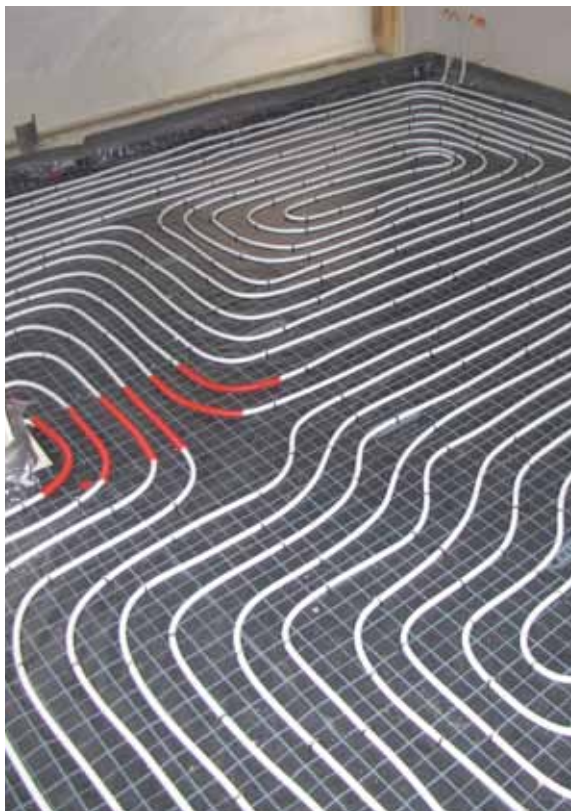
Vloerverwarming op de PUR isolatie
