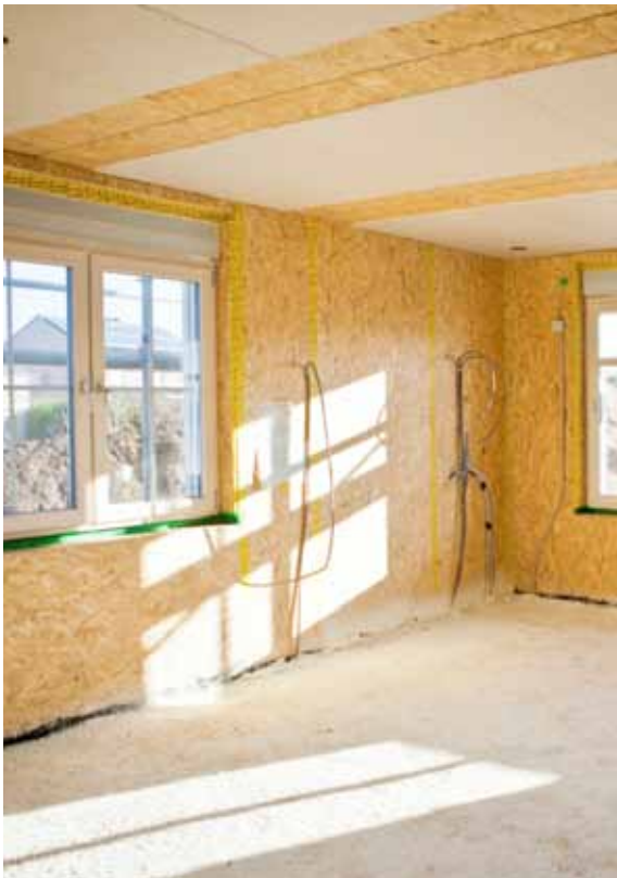
Houtskelet binnenafwerking + PUR isolatie op de vloer
