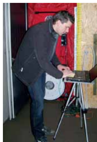
Met behulp van een blowerdoortest wordt de zogenaamde luchtdichtheid gemeten
