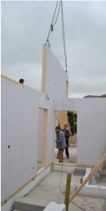
Montage houtskeltbouw, binnenwanden afgewerkt met gyproc
